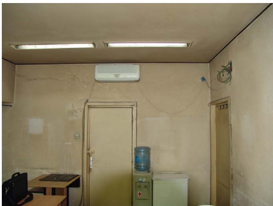
Fig. 4: Vista interna della camera ove e' stata applicata la pittura FOTODECOR
