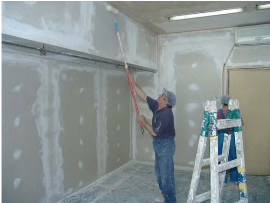
Fig. 5: Applicazione a rullo di FOTODECOR PRIMER
